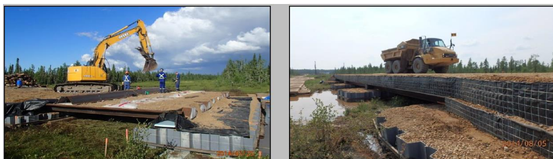
Joonis 35. Plokkidel ehitatud tee märgalal. Foto: Landmark Solutions Ltd. https://www.landmark-solutions.ca/project/49/
