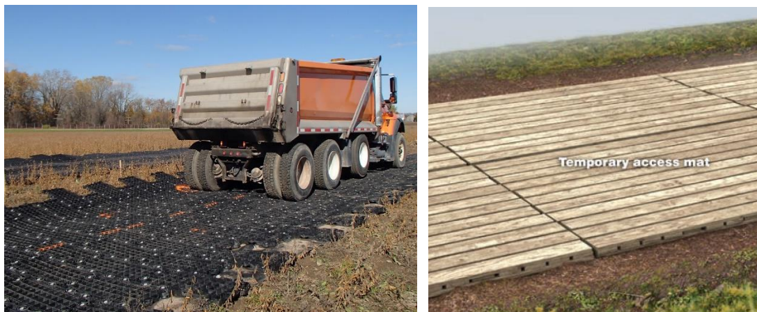
Joonis 32. Ehitusaegsete pinnasetugevdusmattide näidised. Vasakul GeoSystems kummimatid ja paremal puidust paneelid (Partington jt, 2016).
