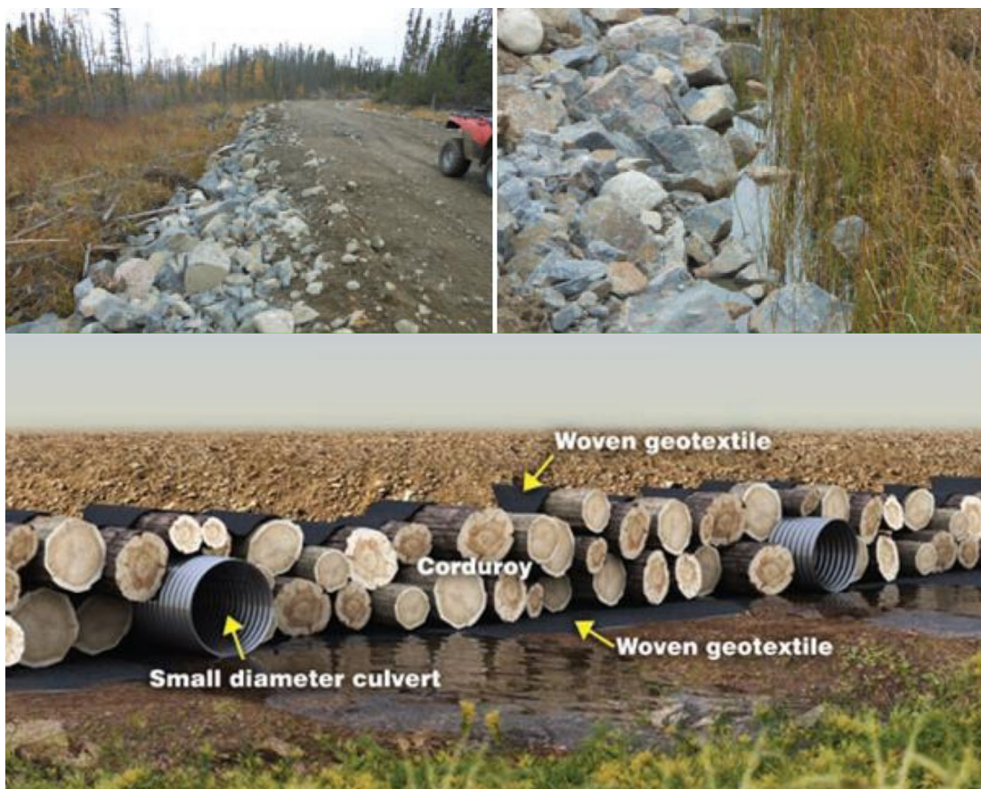
Joonis 34. Vett läbilaskva materjali ja truupide kombineeritud lahendused märgaladele teede ehitamisel (Partington jt 2016).
